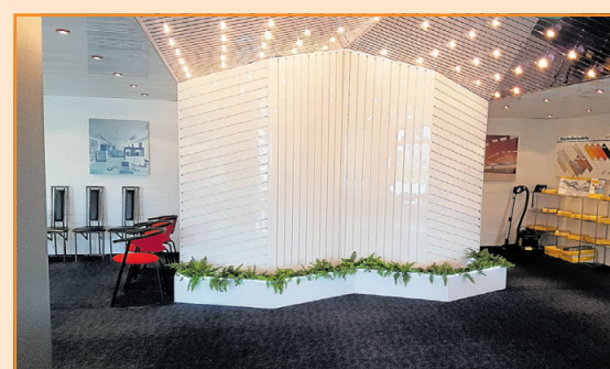
Spritzlackierte Hochglanzwand als Akustikschutz.
